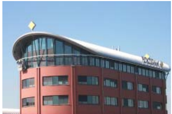
Installatie met bochten ten behoeve van gevelreiniging
